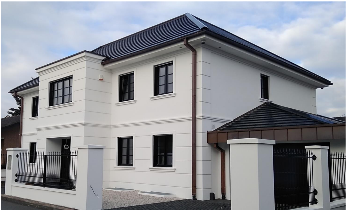
SLB 520 mit schlichter vor Ort geputzter Fensterumrahmung | 3-stufiges Gesimsprofil, bestehend aus GP 12-06 auf Fassadenplatte FPL 595 montiert Pfeilerabdeckungen PAD Spitzdach und Mauerabdeckungen MFD Flachdach, bauseits weiß überstrichen
