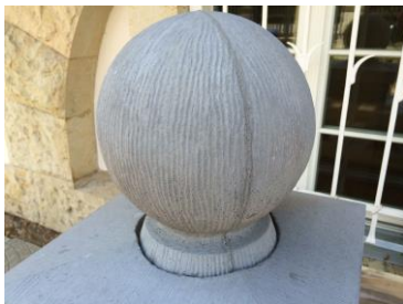
Die Kugel mit Fußteil wird mit dem Unterteil vor Ort verklebt. Die hier noch sichtbare Fuge wird dauerelastisch geschlossen.
