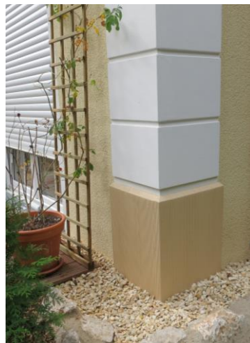
SOP-S zur Betonung der Hausecke Bauseits in beige überstrichen
