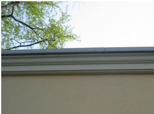
GP 14-06 Gesims mit einer Ansichtshöhe von 13,7 cm
