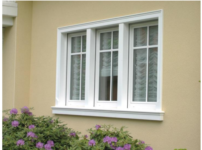
Winkelgewände SLG 100 mit einer Breite von 11,5 cm und leicht genarbter Oberfläche | durchgefärbt weißgrau
