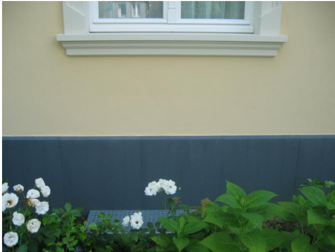
SOP-S mit grob-scharrierter Oberfläche, vor Ort anthrazit gestrichen
