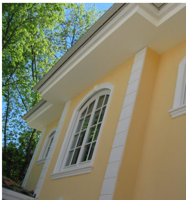
Umrahmung mit Flachgewände FLG 500 und Fensterbank SLB 500
