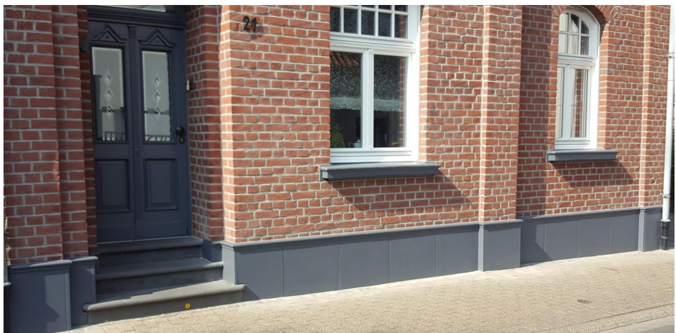
Sockelplatten SOP-G mit glatter Oberfläche und GP 06-05 Gesimsprofil als oberer Abschluss bauseits in anthrazit überstrichen
