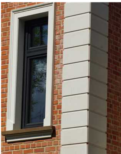
BP-L und BP-R mit Gehrungen zur Betonung der Hausecke
