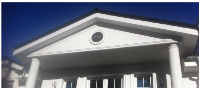
Gesimsprofil GP 14-06 zur Betonung eines Hausgiebels | Gehrungszuschnitt vor Ort Giebel in Kombination mit Niessen Säulen aus Beton
