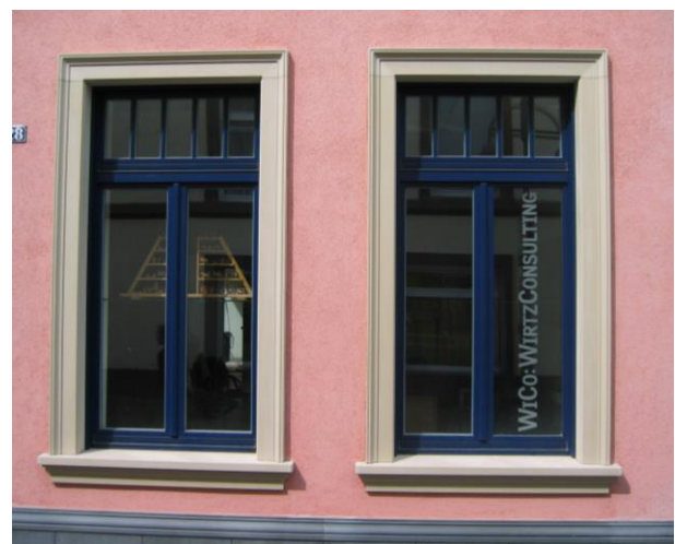
Das Seitengewände und das Kopfgewände werden jeweils mit einer 45 Grad Gehrung geliefert. Breite bzw. Höhe und Tiefe sowie die zweite Gehrung am oberen Kopfgewände können vor Ort zugeschnitten werden. Die Seitengewände werden entsprechend der Neigung der Fensterbank schräg geschnitten. Aus gestalterischen Gründen wurde bei der Fensterumrahmung eine zusätzliche waagerechte Fuge ausgebildet.
