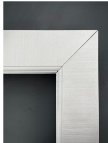
Bei der Montage sollten Fugen zwischen den Elementen vorgesehen werden
