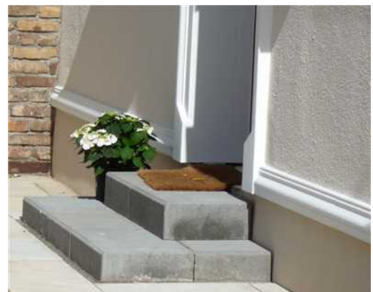
GP 12-03 als oberer Abschluss des Sockelputzes
