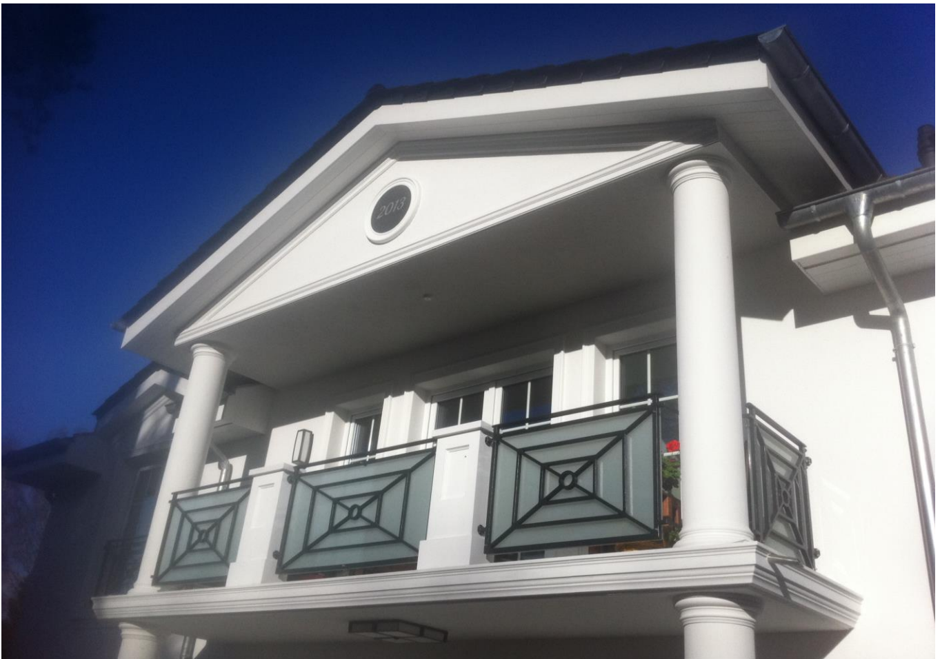
GP 19-10 als Umrahmung der Balkonplatte | Giebel mit Gesimsprofil GP 14-06 | Postamente zwischen dem Geländer | Säulen 01110-30
