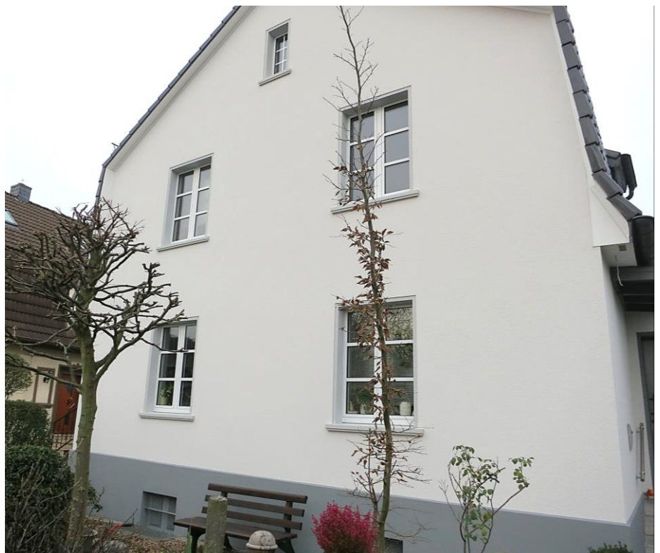
Schalen-Fensterbank SLB 400, passend zu den schmalen Fensterumrahmungen, in hellgrau mit Fassadenfarbe überstrichen
