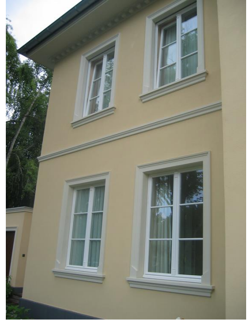
Fensterbank SLB 500 mit Winkelgewände SLG 500. Zur Gliederung der Geschosse wird das Gesimsprofil GP 14-06 eingesetzt.
