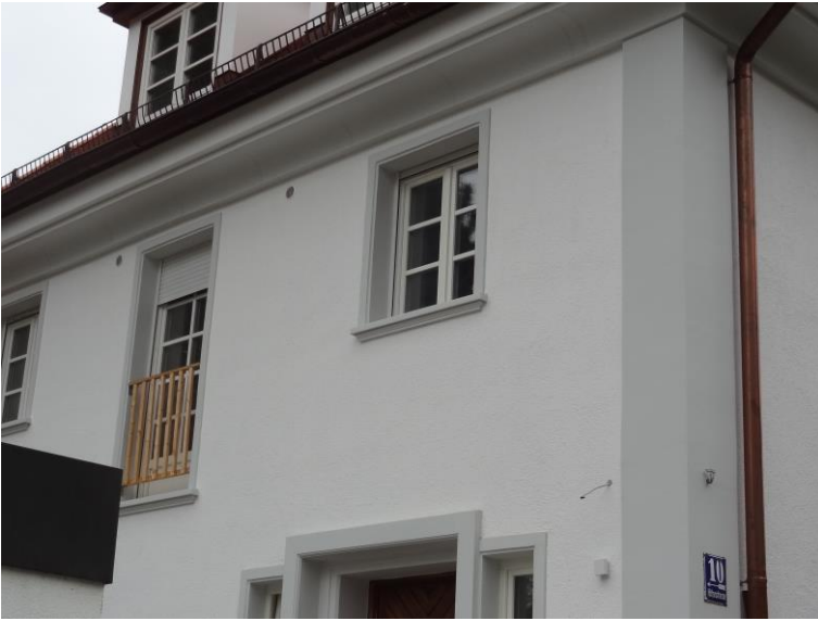
Altbausanierung mit SLB 540 Schalen-Fensterbank in Kombination mit bereits vorhandenen Fensterumrahmungen aus Beton
