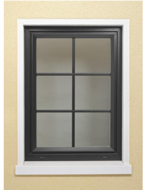
SLB 851 mit glatter Oberfläche in weiß gestrichen Mit passenden weißen ca. 6 cm breiten Faschen
