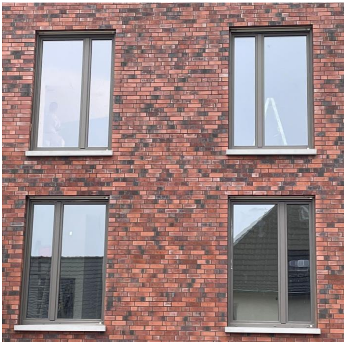
WSB 850 Massiv-Fensterbank in weißgrau mit glatter Oberfläche. Mit unterseitig ausgeprägter Tropfkante.
