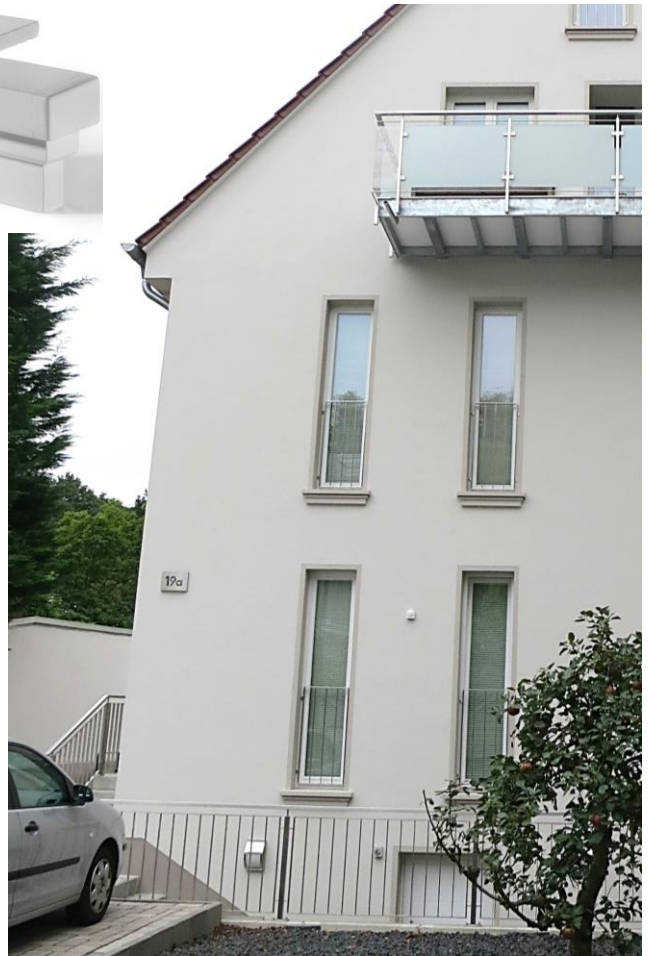
SLB 520 mit farbiger Fensterumrahmung zur Betonung der schmalen hohen Fenster
