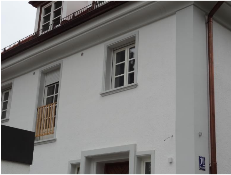
Altbausanierung mit SLB 540 Schalen-Fensterbank in Kombination mit bereits vorhandenen Fensterumrahmungen aus Beton
