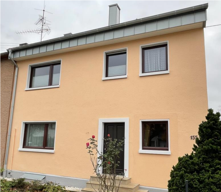
SLB 450 Schalen-Fensterbank mit Ansichtshöhe vorne 15 cm Optisch auffallende geradlinige Fensterbank aus Beton
