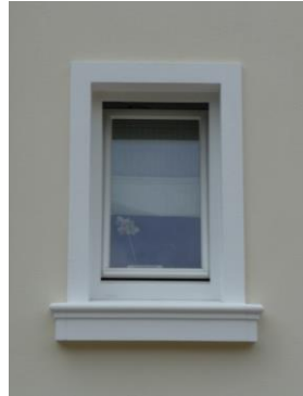
SLB 100 Fensterbank mit bauseits erstellten glatten Putzfaschen.
