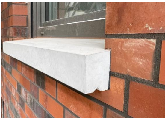
WSB 850 Massiv-Fensterbank durchgefärbt in weißgrau mit unterseitig ausgeprägter Tropfkante
