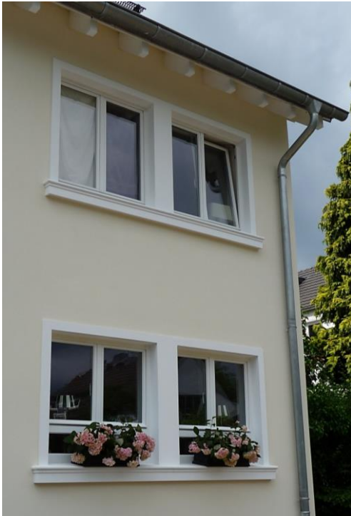
SLB 100 Fensterbank mit bauseits erstellten glatten Putzfaschen.
