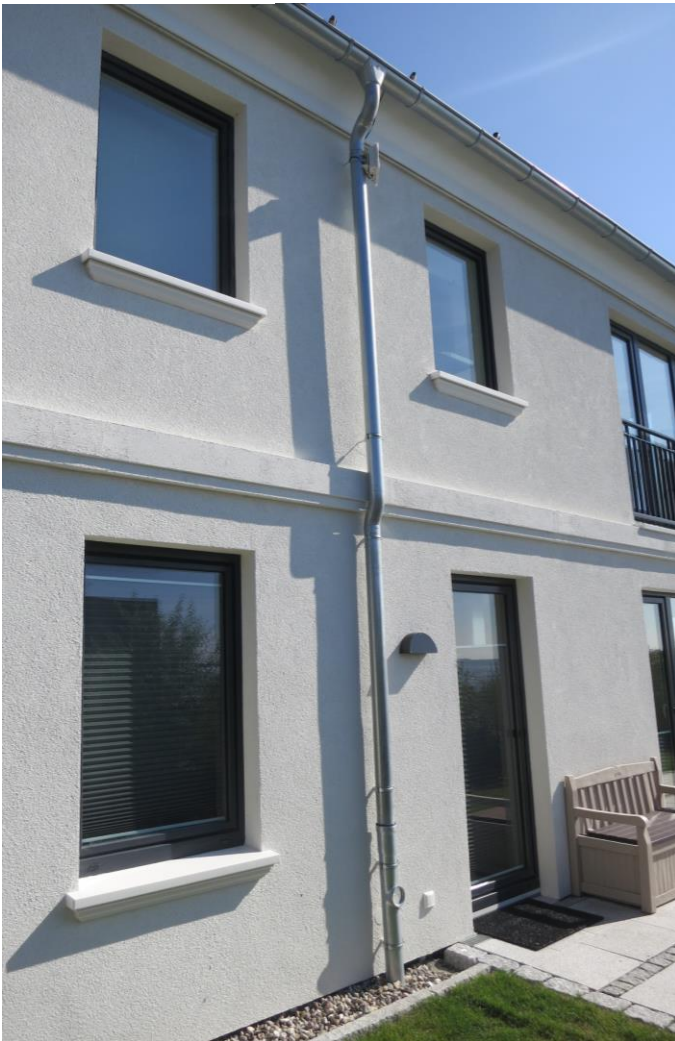
Schalen-Fensterbank SLB 550 mit Abdeckplatte und profiliertem Untersims | Höhe 11,5 cm
