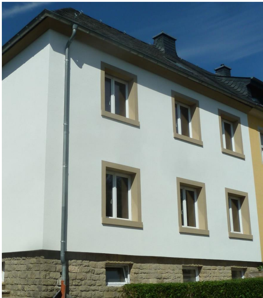
Hausfassade bei der die Fensterumrahmungen mit der Fensterbank seitlich abschließen
