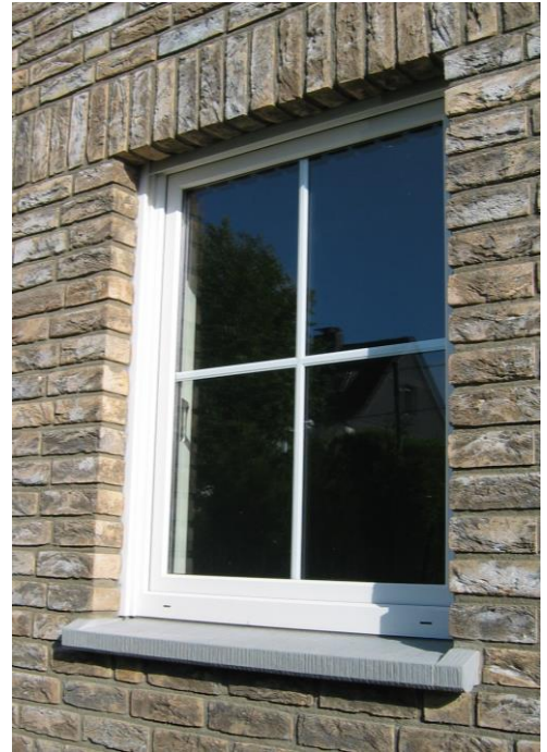
WSB 900 durchgefärbt mittelgrau mit seitlichen Aufkantungen jeweils 6 cm
