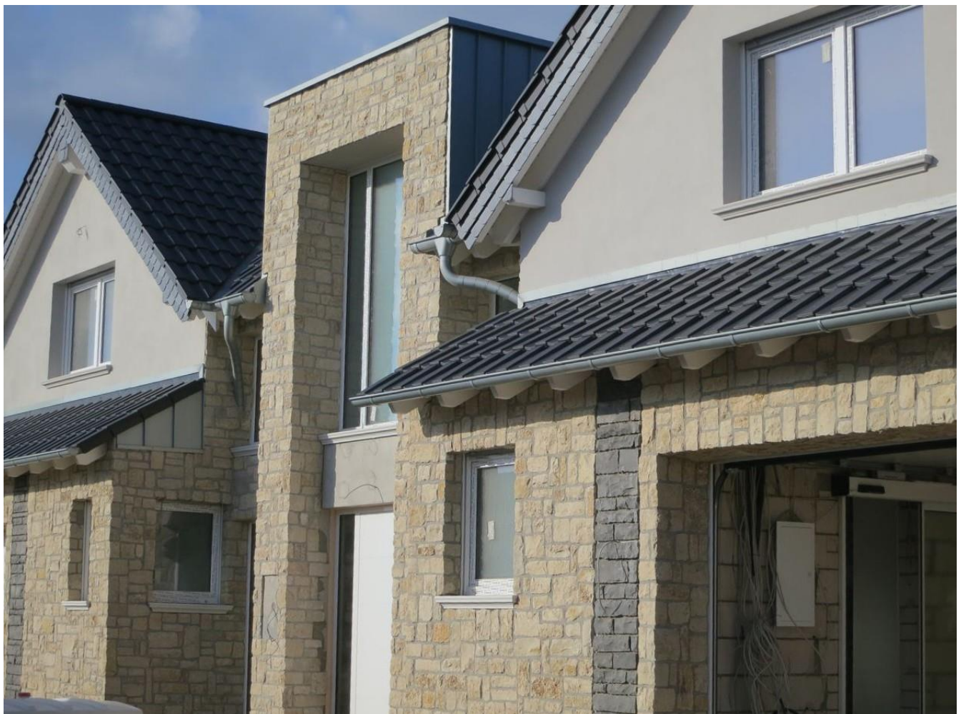
SLB 541 Schalen-Fensterbank mit Höhe 9 cm und Flachgewände FLG 110 mit Breite 8 cm
