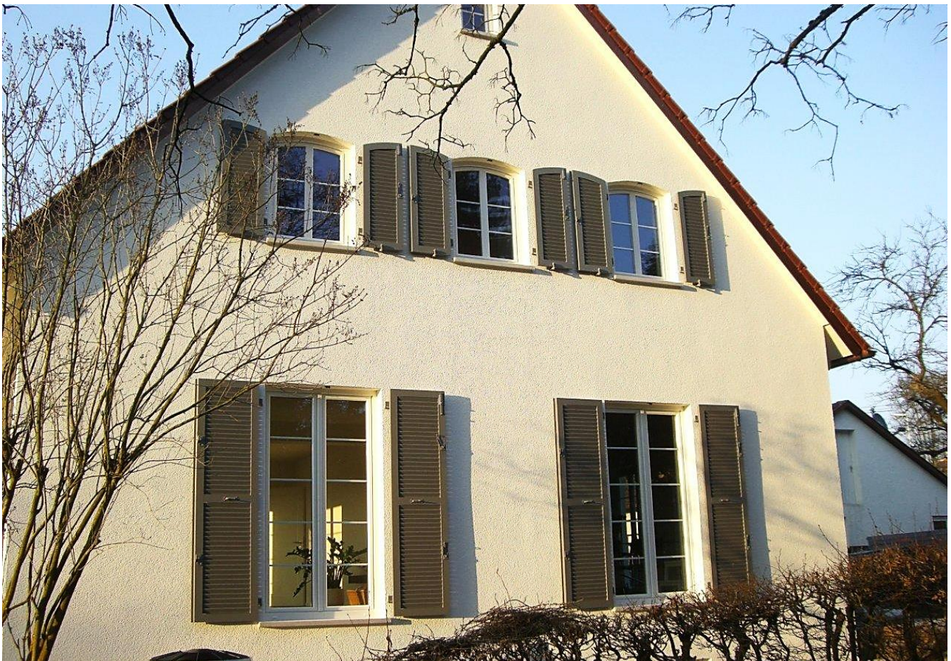
SLB 591 Fensterbank aus Beton, farbig gestrichen, mit Holzfensterläden, schicke optische Alternative zu Alu- oder Granitfensterbänken
