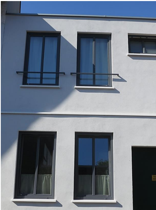
SLB 591 Schalen-Fensterbank mit Höhe 4,5 cm Moderne und schlichte Fensterbank aus Beton
