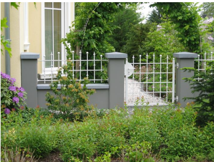
PAD Pfeilerabdeckung Spitzdach und MAD Mauerabdeckung Satteldach
