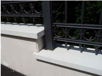
MFU Endstück mit umlaufenden Rand an einer Stirnseite, durchgefärbt weißgrau. Die Mauerabdeckung MFD an der tiefer liegenden Mauer wurde bauseits ausgeklinkt.
