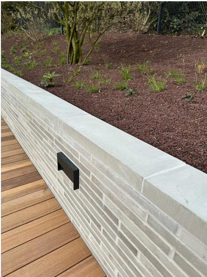
MAP Pulldachabdeckung mit fein-scharrierter Oberfläche, in betongrau
