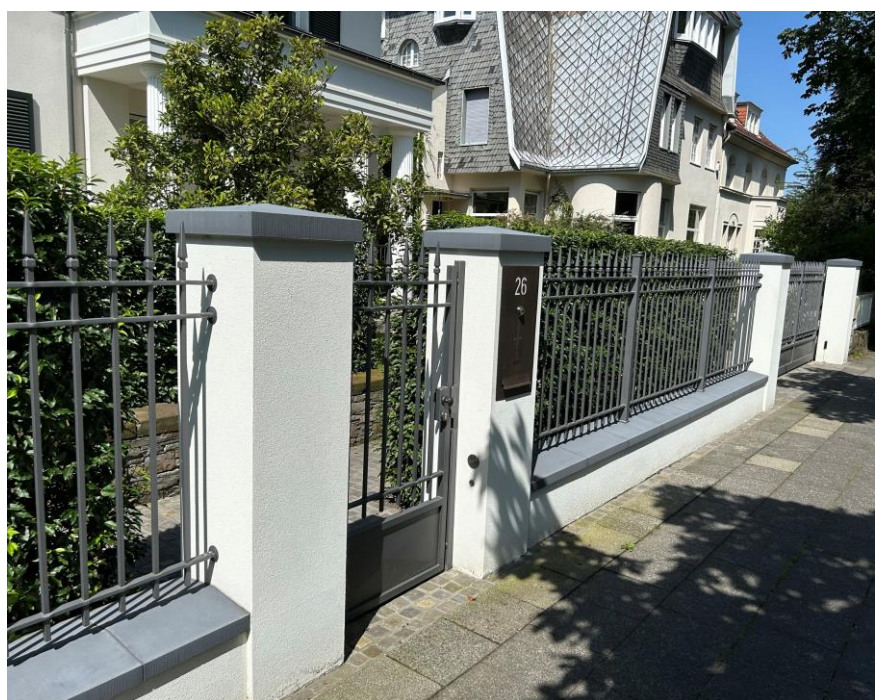
Zaunanlage mit Satteldachabdeckungen MAD und Pfeilerabdeckungen PAD Spitzdach
