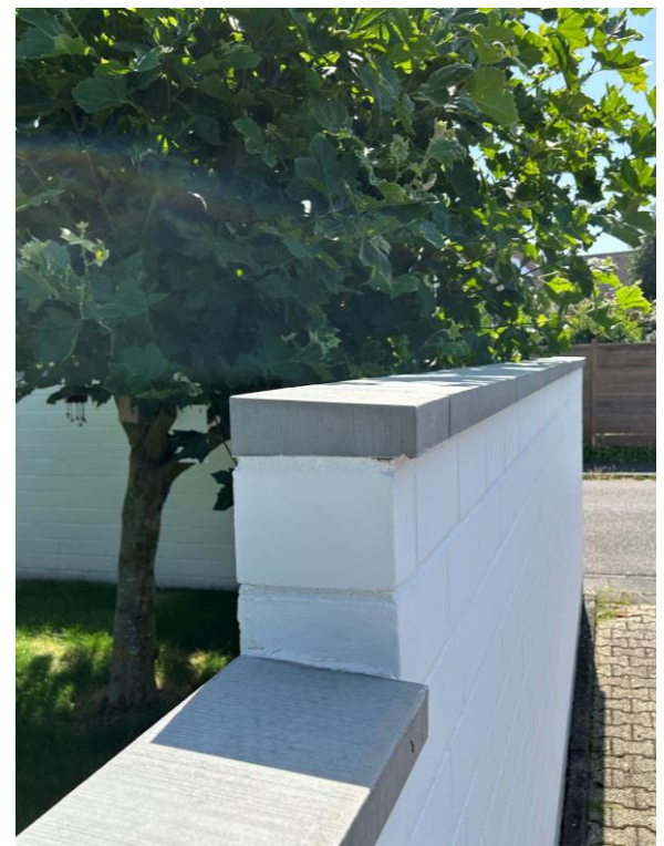
MAP Pulldachabdeckung einseitig bündig mit einer weißen Kalksandsteinmauer, Abdeckung durchgefärbt in mittelgrau
