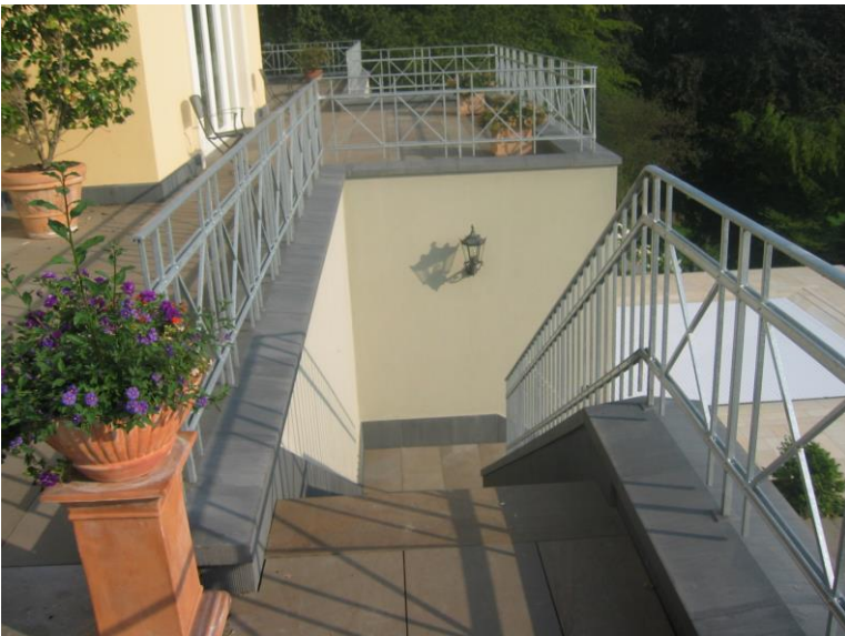
MAD Mauerabdeckung Satteldach, durchgefärbt mittelgrau
