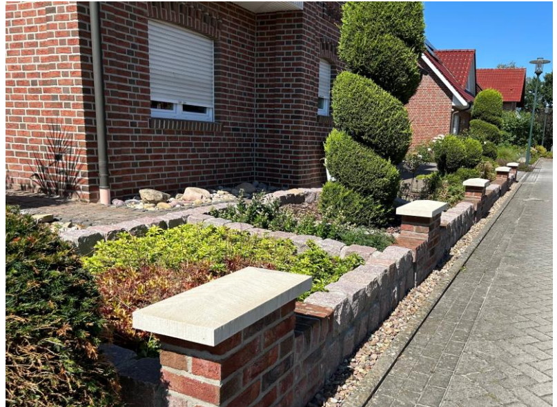
PAR Pfeilerabdeckung Walmdach rechteckig, durchgefärbt betongrau
