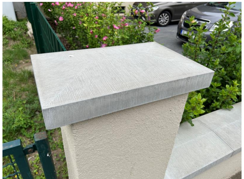
PAR Walmdach rechteckig, durchgefärbt betongrau
