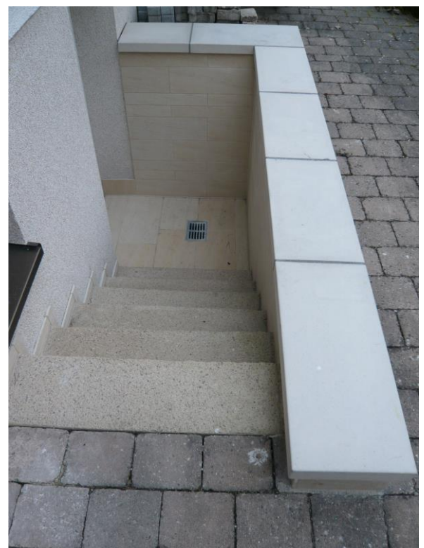
MFD Flachdach und MFU Endstück durchgefärbt in weißgrau. Die 90 Grad Ecke der Mauer wurde mit einem Endstück MFU, das unterseitig in Mauerbreite ausgeklinkt wurde, ausgeführt.
