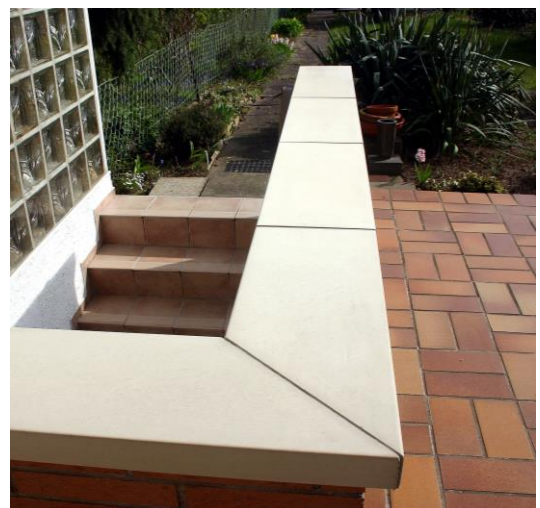
Eckausbildung mit 2 Mauerabdeckungen MFD Flachdach. Die Abdeckungen wurden vor Ort auf Gehrung geschnitten.
