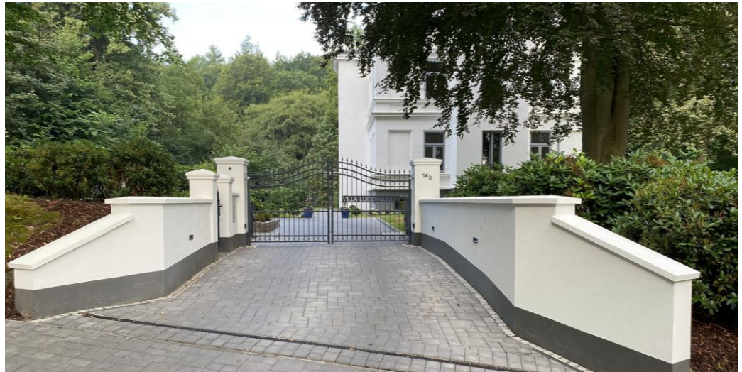
MAD Mauerabdeckungen Satteldach und PAD I Exklusiv Pfeilerabdeckungen, bauseits weiß gestrichen. Für die Mauerenden wurden die Endstücke MPU verwendet.
