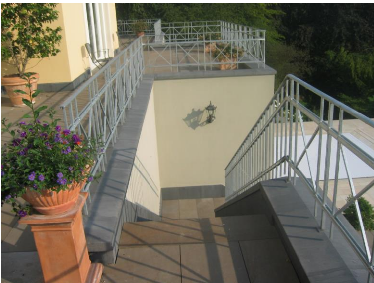
MAD Mauerabdeckung Satteldach und MPU Endstück, durchgefärbt mittelgrau
