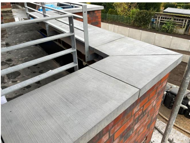
Eckausbildung 90 Grad mit zwei MAP Pultdachabdeckungen. Die Abdeckungen wurden vor Ort auf Gehrung geschnitten.
