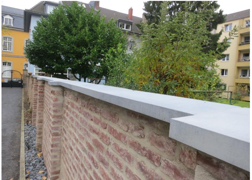
PAP Pfeilerabdeckungen und MAP Mauerabdeckungen Pultdach, durchgefärbt mittelgrau
