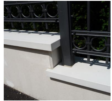
MFU Endstück Flachdach weißgrau mit einseitig geschlossenem Ende und MFD mit bauseits erstellter Ausklinkung
