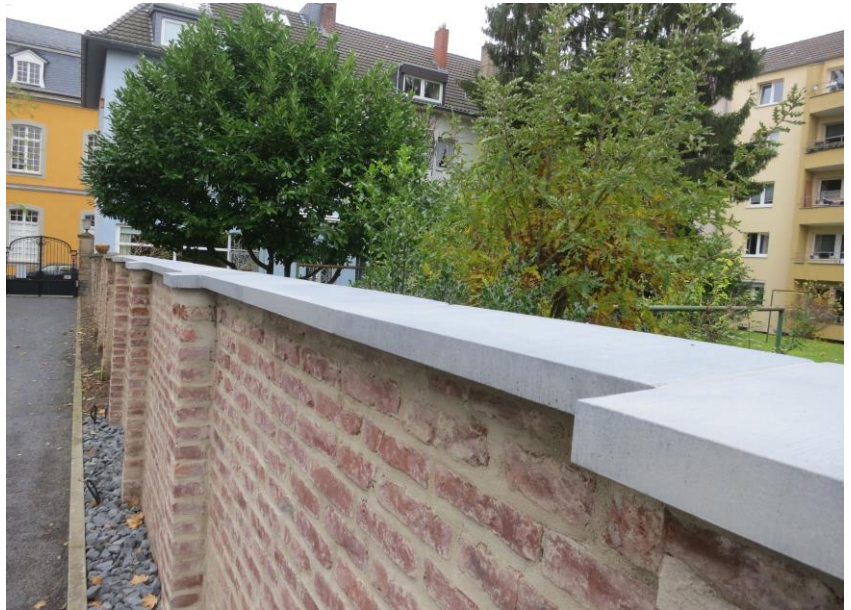
MAP Mauerabdeckungen Pulldach und PAP Pfeilerabdeckungen, durchgefärbt mittelgrau
