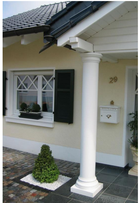
Hohlsäule 01121-25 mit K1 Kapitell Serlio + S1 Schaft + B2 Basis Serlio mit Ring + P1 Plinthe
