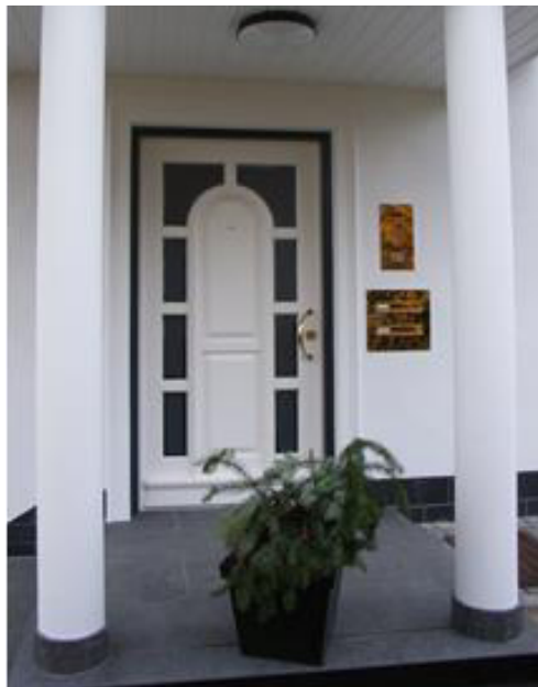
Hohlsäule 00100-25 mit S1 Schaft Fuß der Säule mit Granit verkleidet (bauseits)
