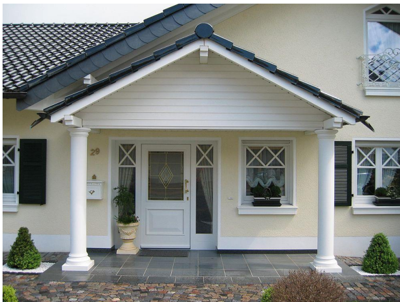
Hohlsäule 01121-25 mit K1 Kapitell Serlio + S1 Schaft + B2 Basis Serlio mit Ring + P1 Plinthe (Vordach und tragende Holzkonstruktion bauseits)
