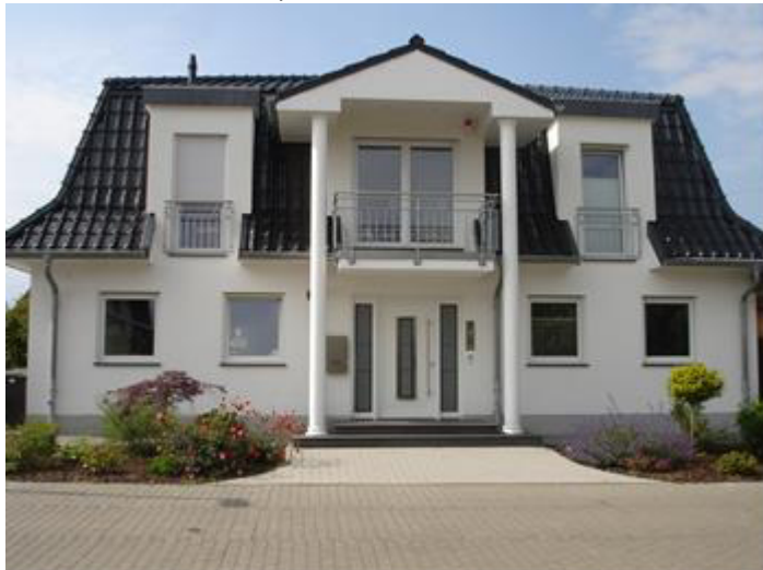
Hohlsäule 11111-30 | Höhe ca. 6 Meter
