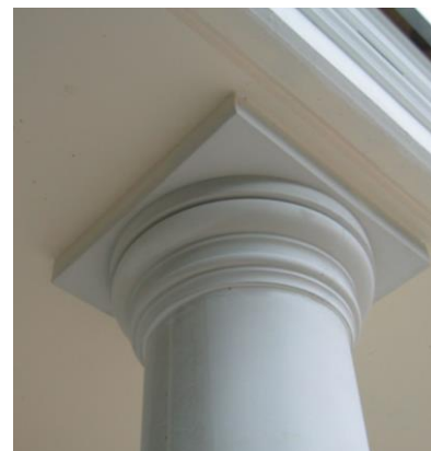
Oberer Abschluss der Hohlsäule 12121-30 mit A1 Abakusplatte + K2 Kapitell Serlio mit Ring
