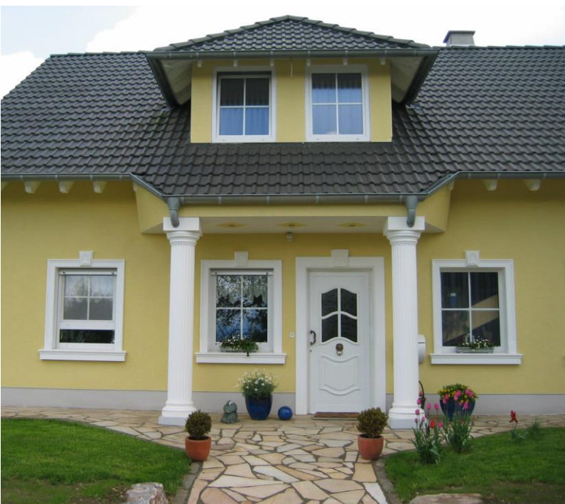
Hohlsäule 12521-30 mit A1 Abakusplatte + K2 Kapitell Serlio mit Ring + S5 Schaft kanneliert + B2 Basis Serlio mit Ring + P1 Plinthe
