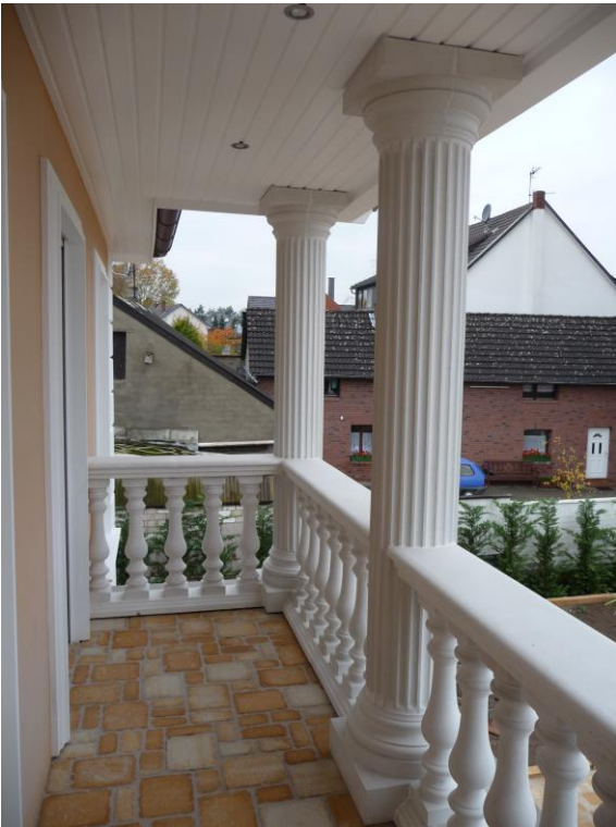
Hohlsäule 12521-30 mit A1 Abakusplatte + K2 Kapitell Serlio mit Ring + S5 Schaft + B2 Basis Serlio mit Ring + P1 Plinthe
