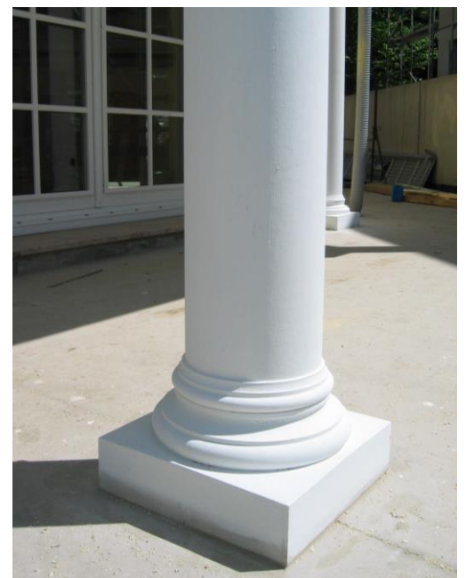
Unterer Abschluss der Hohlsäule 11111-30 mit B1 Basis Serlio + P1 Plinthe
