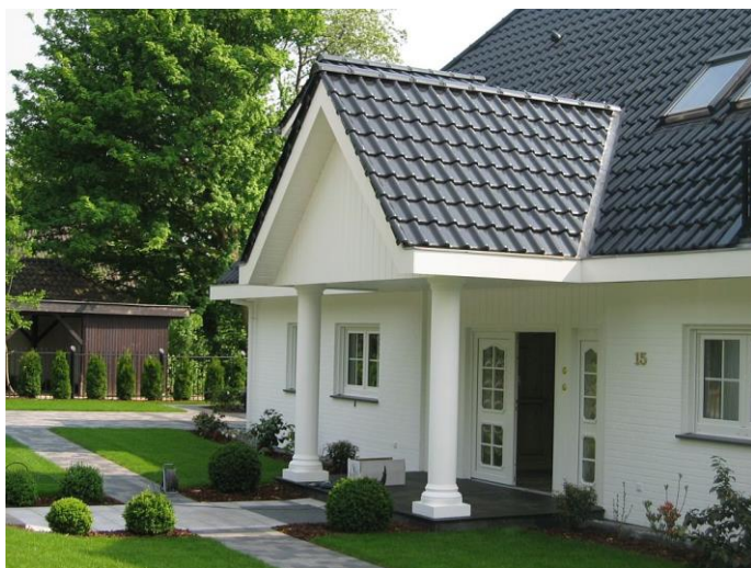
Hohlsäule 01121-30 mit K1 Kapitell Serlio + S1 Schaft glatt + B2 Basis Serlio mit Ring + P1 Plinthe
