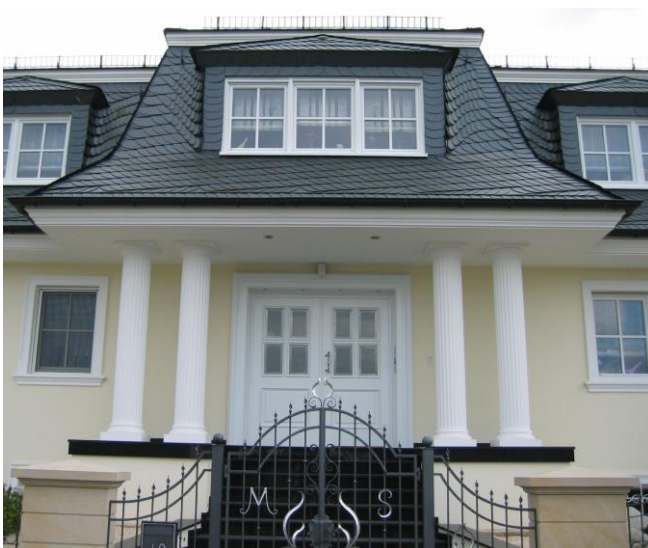
Hohlsäule 01111-30 mit K1 Kapitell Serlio + S1 Schaft + B1 Basis Serlio + A1 Plinthe
