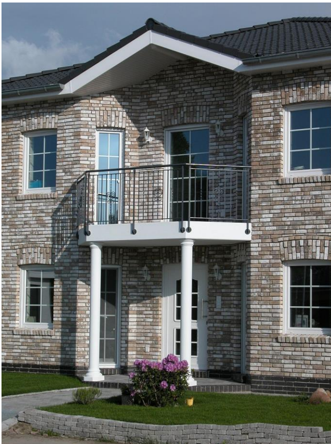
Hohlsäule 01111-25 mit K1 Kapitell + S1 Schaft + B1 Basis Serlio + P1 Plinthe
